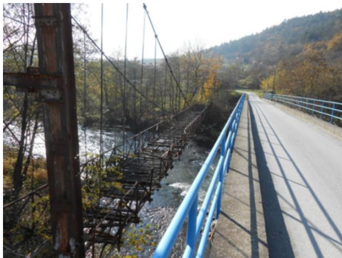
Слика 5: Мост на Ибру у Пустом пољу (поред старог висећег пешачког моста изграђен је нов армирано-бетонски друмско-пешачки мост)
