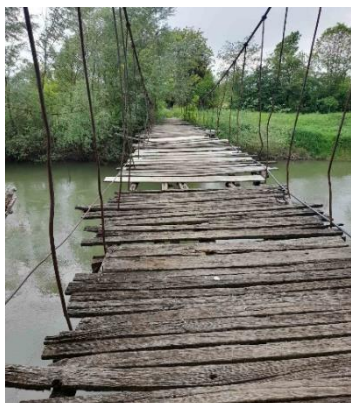
Извор: ДРИ – Висећи мостови у Краљеву: небезбедан мост за коришћење на Западној Морави (слика лево) и безбедан мост за коришћење на Ибру у Матарушкој Бањи (слика десно)
